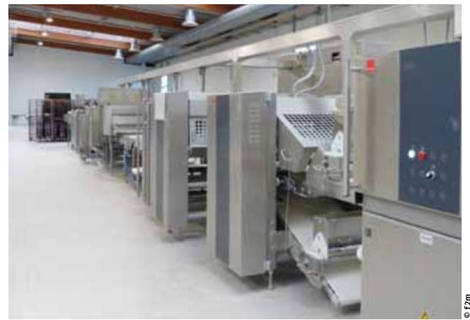
++ Im Produktionsbereich TK stehen vier Linien, die automatisiert arbeiten. Produziert werden z. B. Kleingebäcke oder Baguettes
